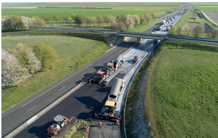
Dans le cadre de la réfection des chaussées sur l'autoroute A26, l'entreprise TRABET s'est installée sur la plateforme SANEF située sur la commune de Mailly-le-Camp. Les travaux consistaient au renouvellement des couches de roulement et, ponctuellement, de la liaison, afin de permettre la circulation des usagers de l'autoroute en toute sécurité.
